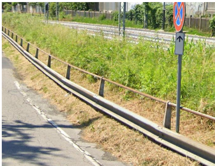
Figura 16 – Attuale Barriera metallica di sicurezza
