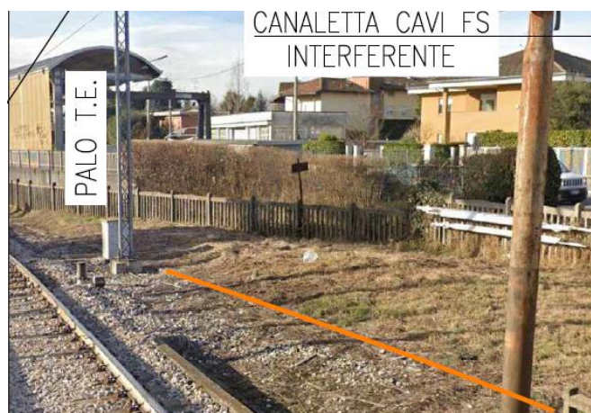
Figura 5 – Vista in arancione della canaletta cavi FS lato via A.Diaz
